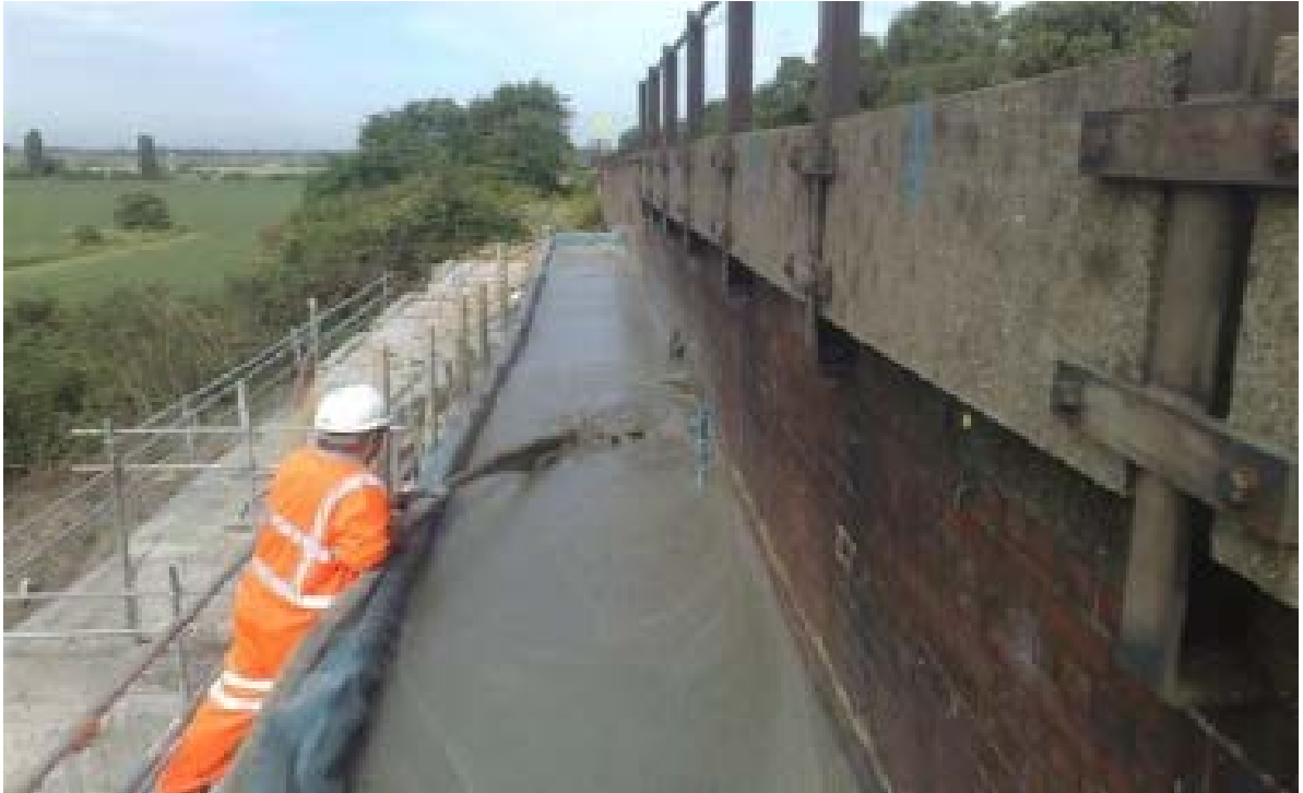
Рис. 7 - последняя заливка в заполнении окончательной лифт
