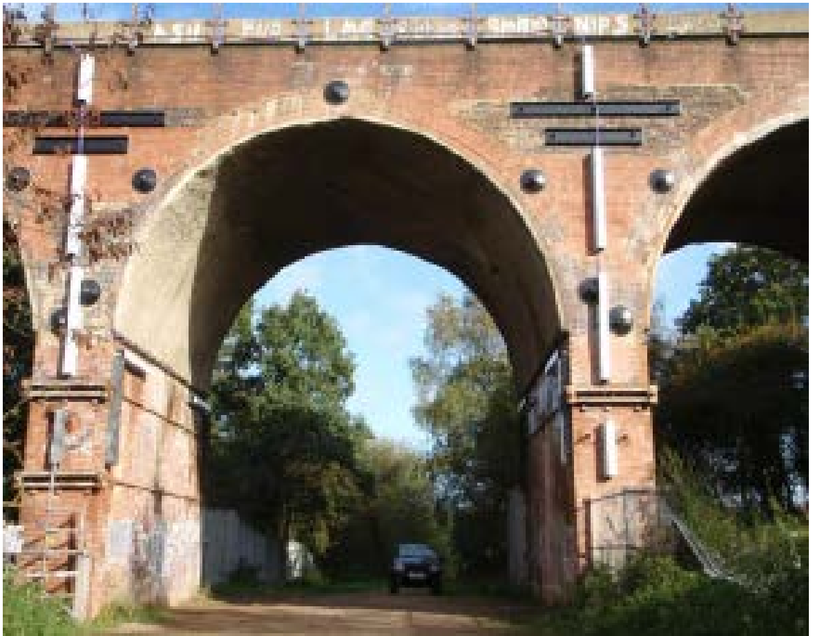
Рисунок 1 - Арки также укрепляются в сочетании с мониторингом устройств, записывающих нагрузки при движении поездов.
