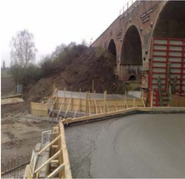
Рисунок 2 – Начало заливки.
