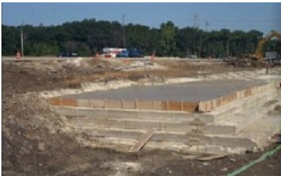
Рисунок 2 - Ступенчатая и последовательная заливка.
