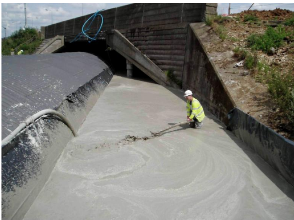
Рисунок 1 - Заливка пенобетоном.
