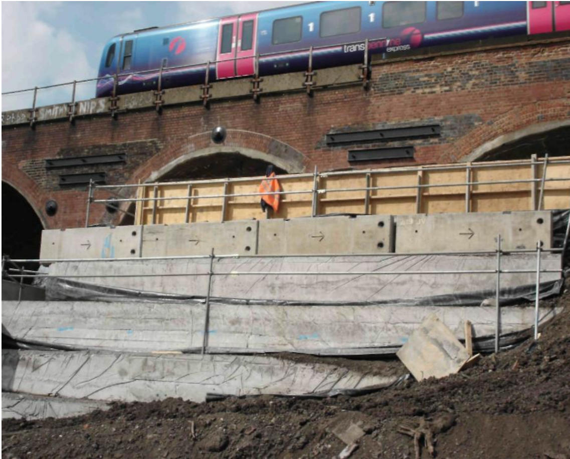
Рисунок 2 - Ступенчатая и последовательная заливка.
