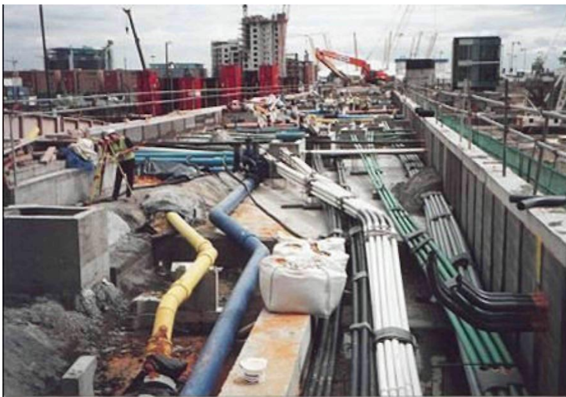
Рисунок 8 - Пенобетон заливают на коммуникации.
