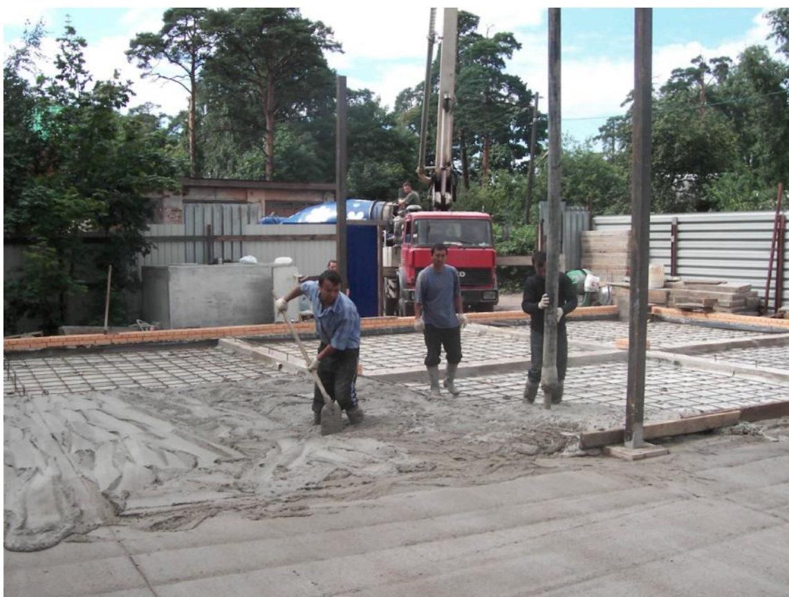
Рис. 5 - Укладка приготовленного на месте пенобетона.
